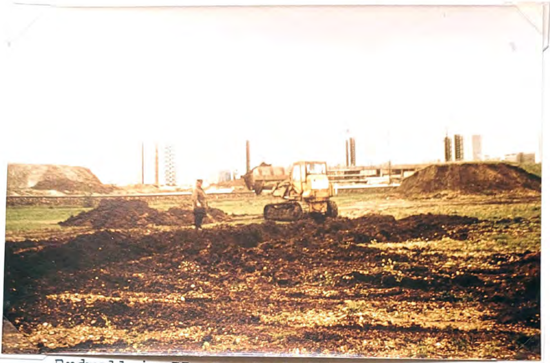
Erdwall im II. Bauabschnitt
