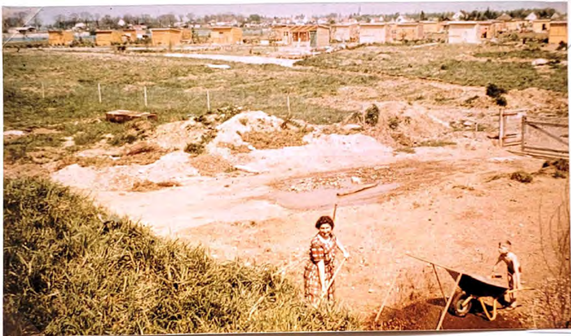
II. Bauabschnitt vor der Rodung
