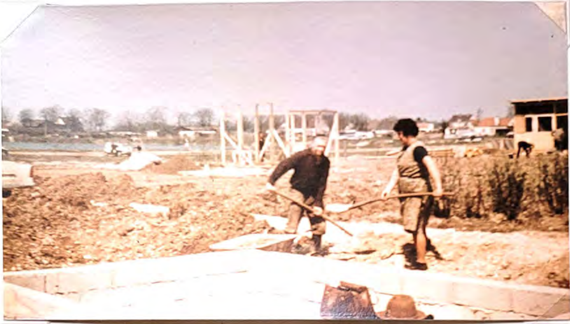
Ansicht eines genehmigten Fundaments
